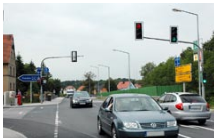
Stationäre Lichtsignalanlage in Hermsdorf (A4/B97)
