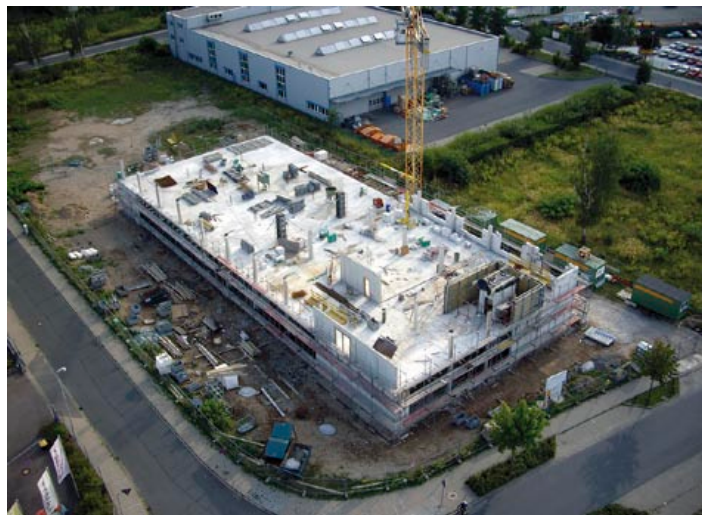
Baufortschritt am 21. August 2008
