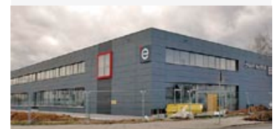
Baufortschritt Firmenneubau Februar 2009
